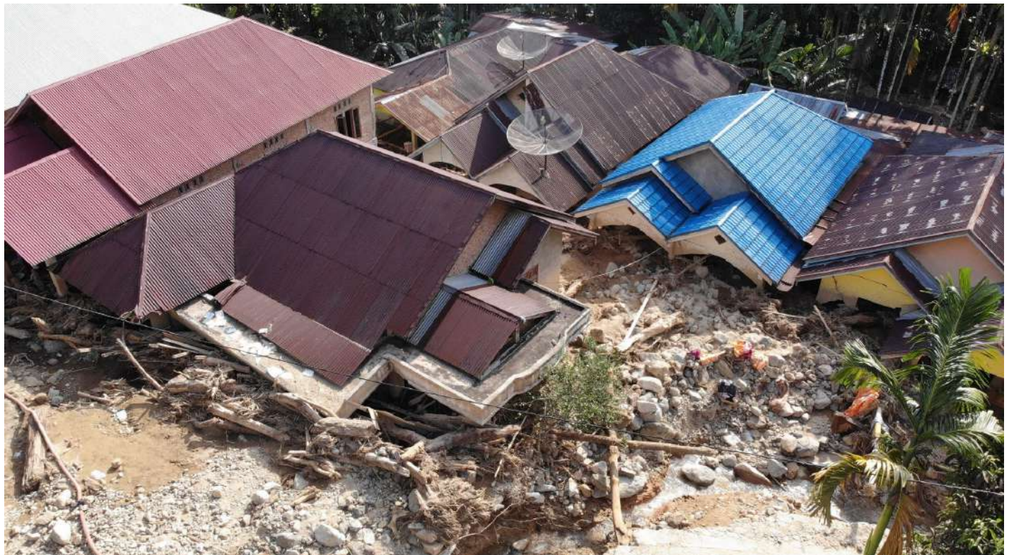
Gambar 18. Dampak banjir dan tanah longsor di Kampung Tanjung Desa Duku Utara, Kec. Koto XI Tarusan, Kab. Pesisir Selatan
