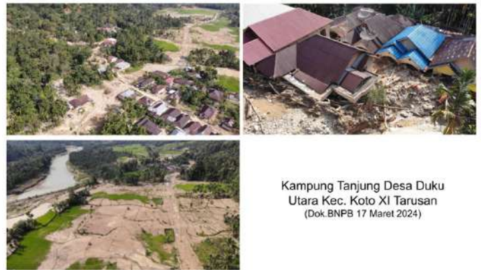
Gambar 25. Lokasi terdampak bencana di Kampung Tanjung Desa Buku Utara
